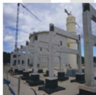
Gazport Świnoujście 2012-2014 41,5 mln PLN
