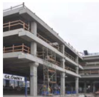
Dworzec PKP i parking Poznań 2011-2013 28 mln PLN
