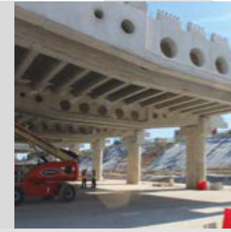
Dworzec Łódź Fabryczna 2014-2016 43,7 mln PLN
