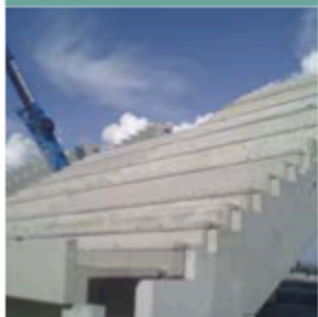
PREFABRYKATY NA BUDOWĘ STADIONÓW
