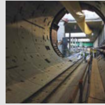
Tunel pod Martwą Wisłą Gdańsk 2013-2014 44,9 mln PLN
