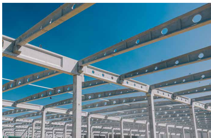
fot. 4. Dach hali wykonany w technologii prefabrykacji strunobetonowej [PEKABEX]
