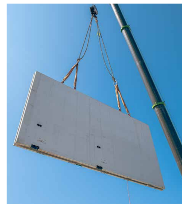
Element ścienny na placu budowy
