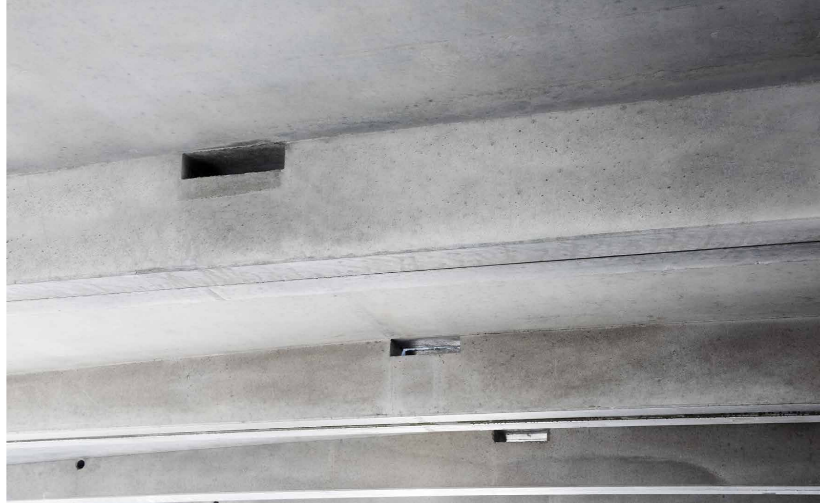
Elementy konstrukcji parkingu, Kotobrzeg
