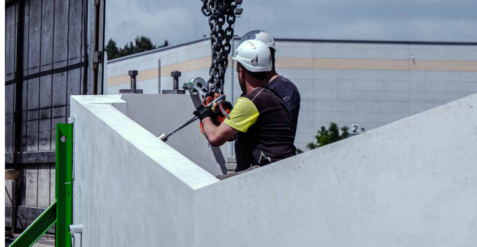
Pracownicy Pekabex, magazyn Pekabex
