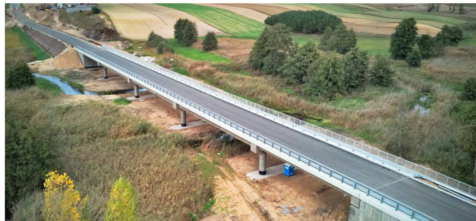
Konstrukcja żelbetonowa mostu w Lubrańcu
