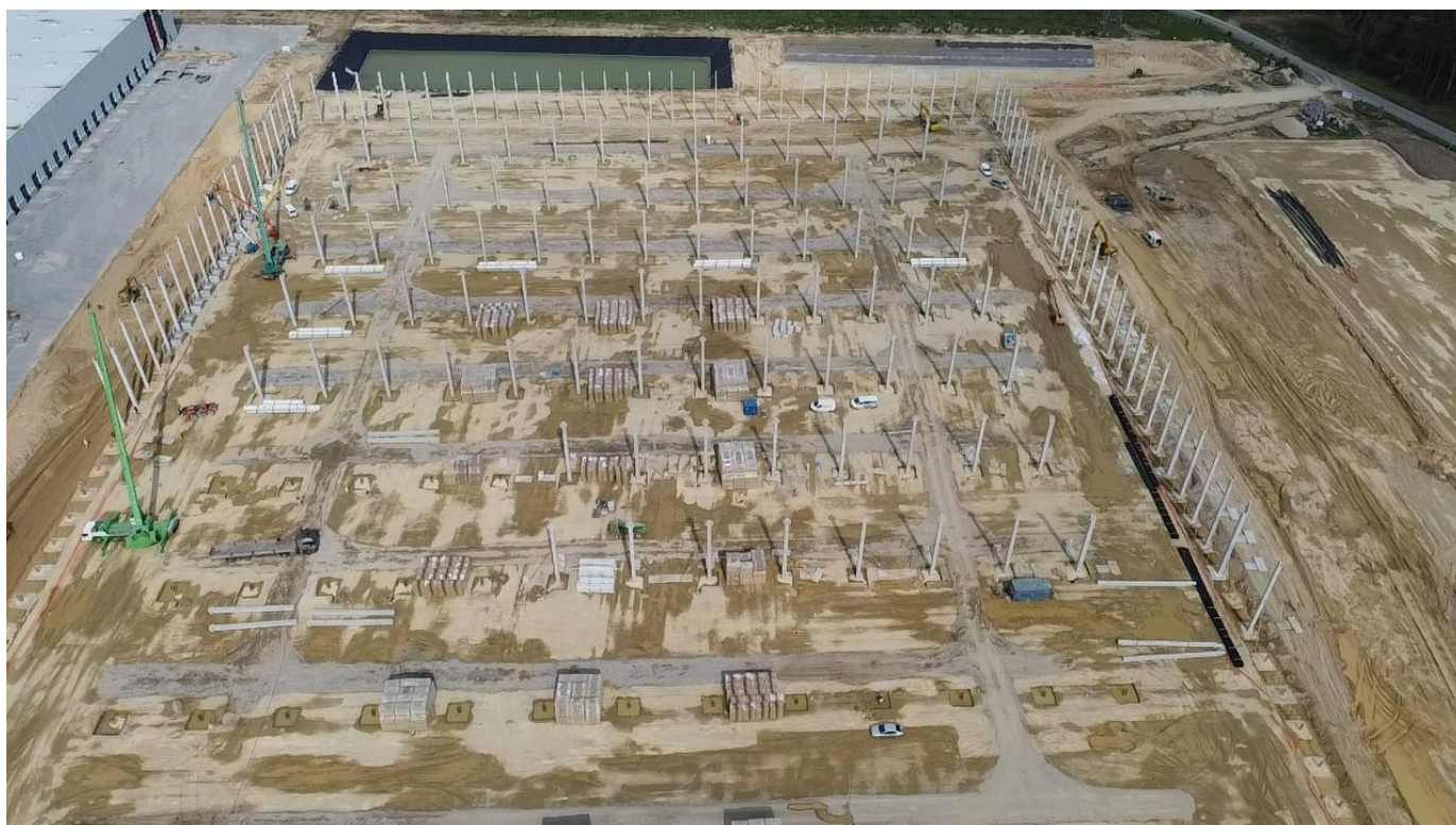
Fot. 5 – Drogi widok z góry.
