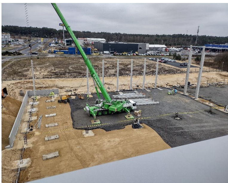
Fot. 3 – Praca żurawia na platformie
