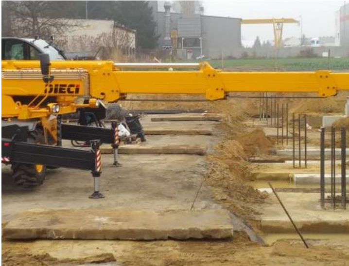
Fot. 6 – Poprawnie przygotowany teren pod płyty.
