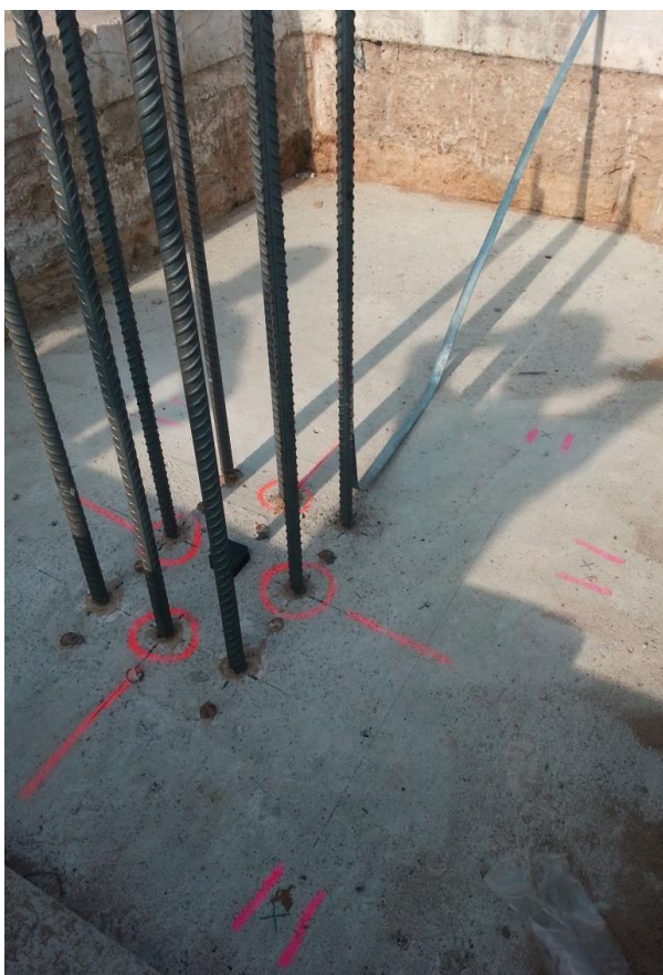
Fot. 9 - Przykład osi naniesionych prawidłowo na fundament
