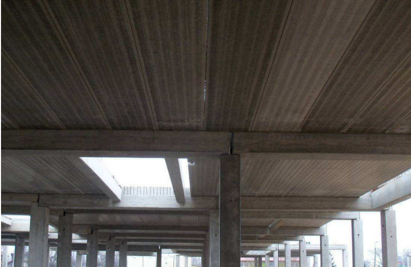
Fot. 14 - Widok dolnej powierzchni płyt stropowych
