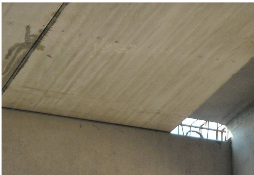
Fot. 19 - Widok dolnej powierzchni płyt kanałowych HC z otworami drenażowymi
