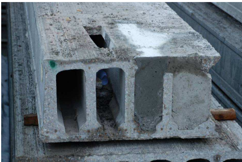
Fot. 20 - Przykładowe naprawy płyt HC
