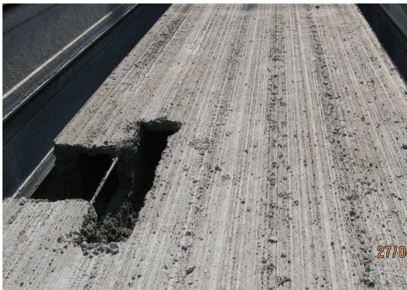
Fot. 12 - Widok szorstkiej, górnej powierzchni płyt stropowych
