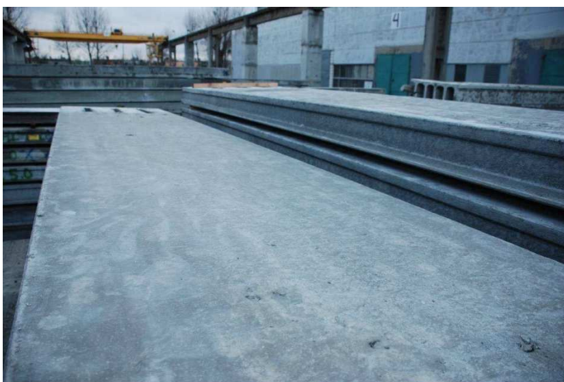
Fot. 13 - Widok gładkiej, górnej powierzchni płyt stropowych
