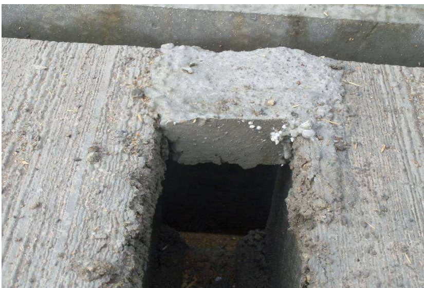
Fot. 21 - Przykładowe naprawy płyt HC
