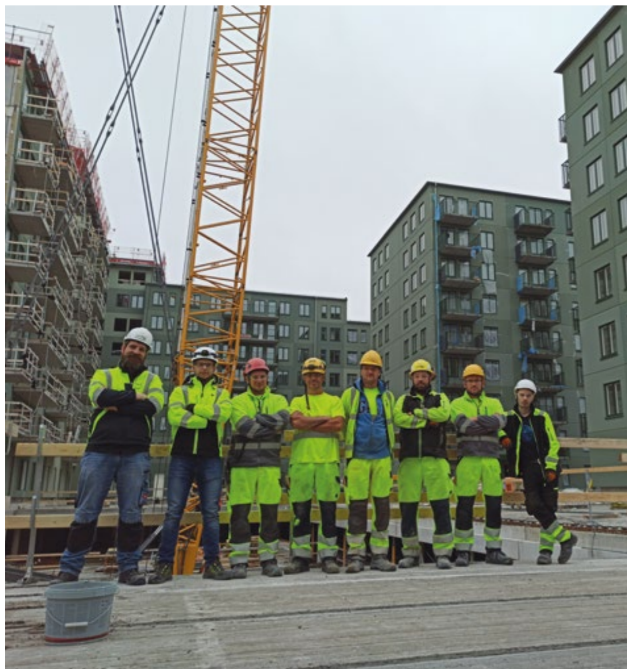
Ekebackshöjd construction site, Goteborg
