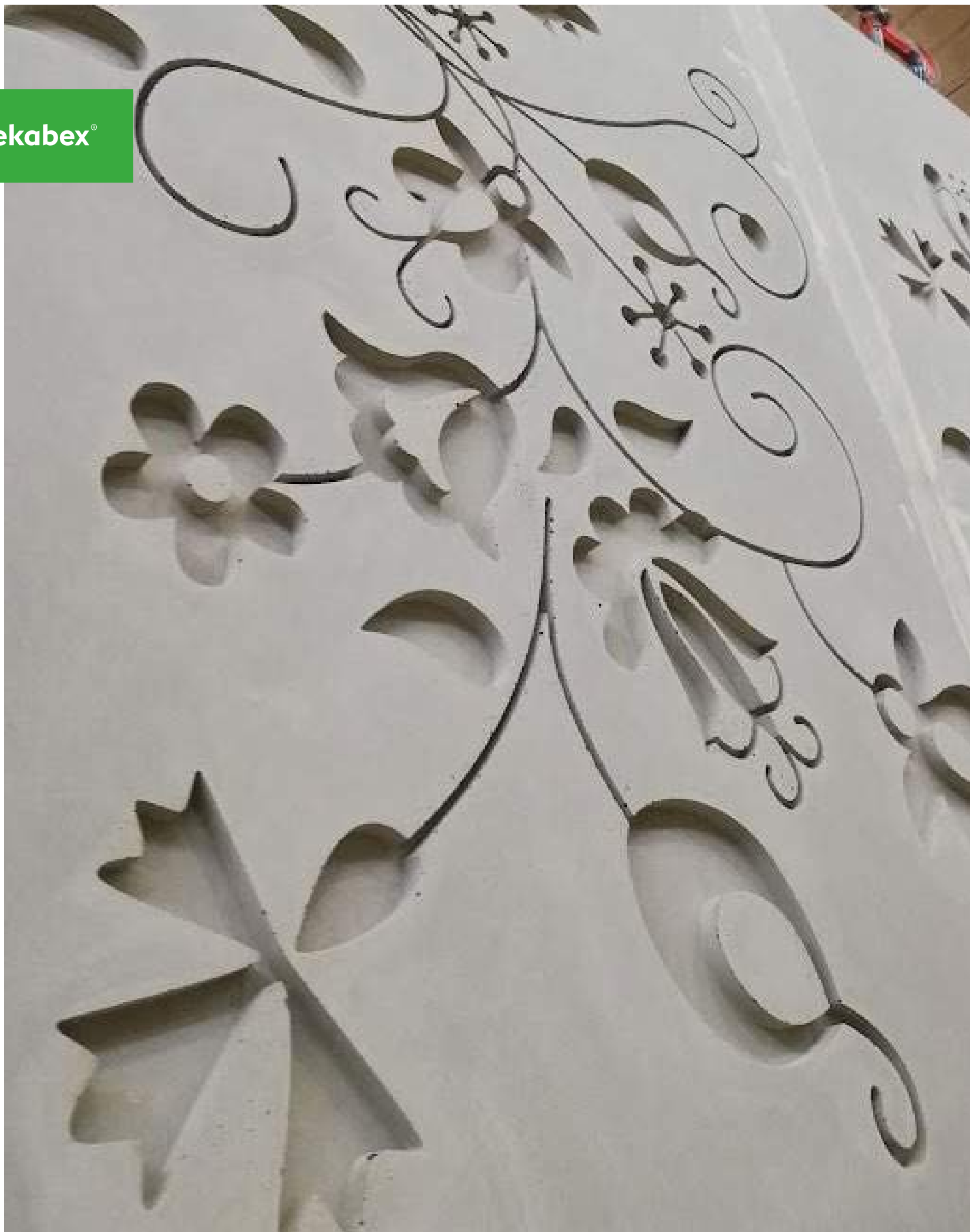
Ściana prefabrykowana z matrycą, Pekabex Gdańsk
