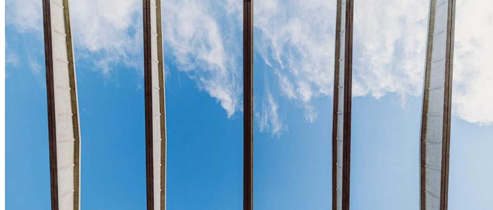
Hala SK Innovation, Dąbrowa Górnicza
