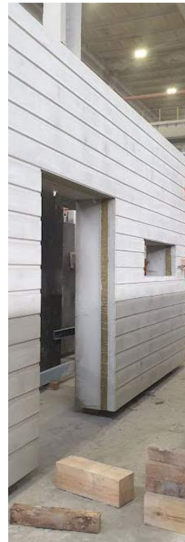
Prefabrykowana ściana trójwarstwowa, Pekabex Gdańsk
