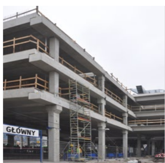
Dworzec PKP i parking Poznań 2011-2013 28 mln PLN
