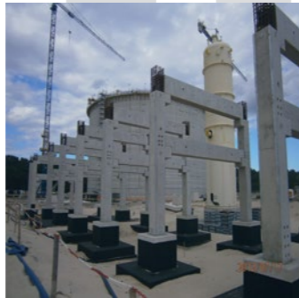
Świnoujście LNG Terminal 2012-2014 PLN 41.5 million
